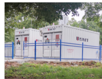
明基医院项目
